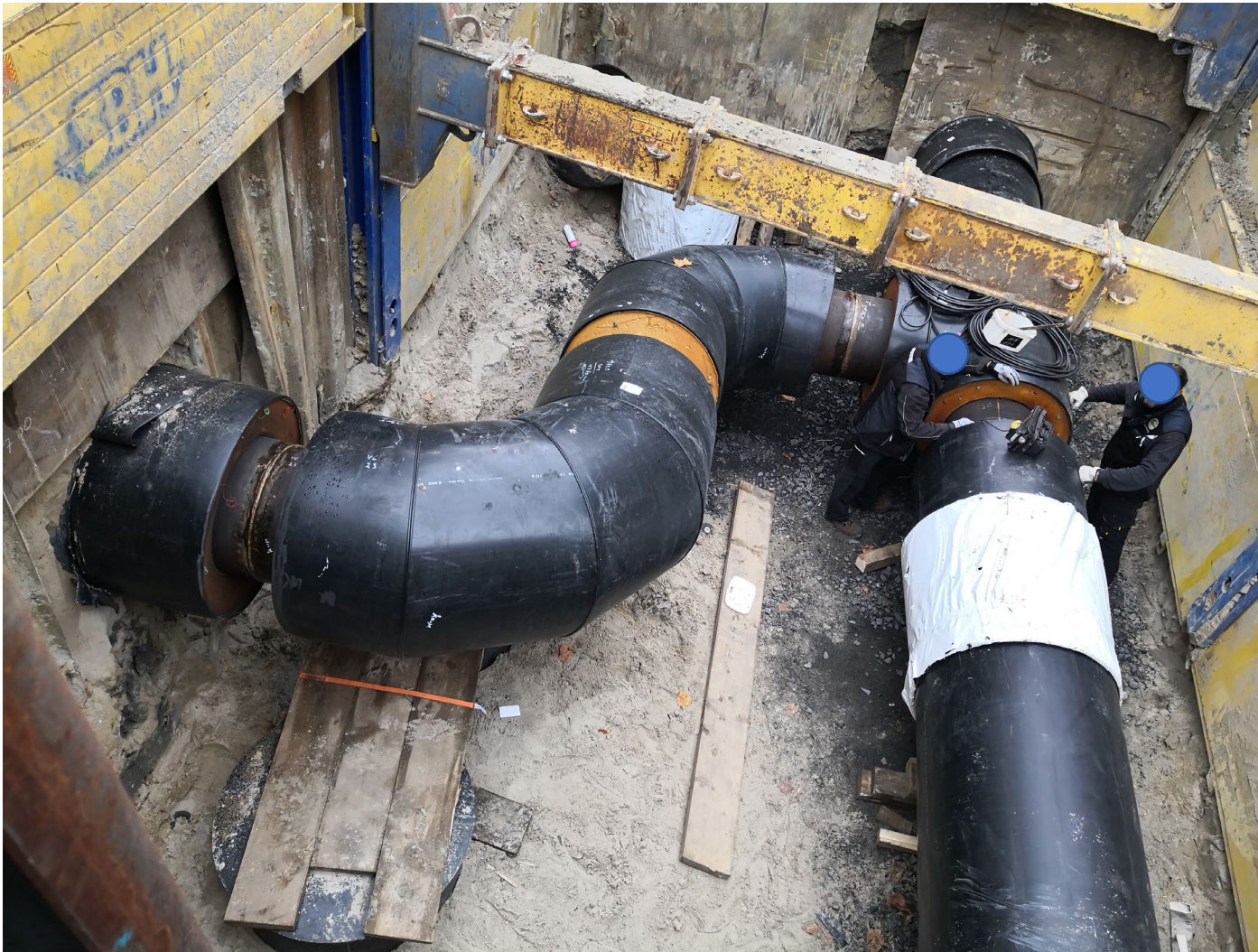
Abbildung: Abzweig DN 600/600
