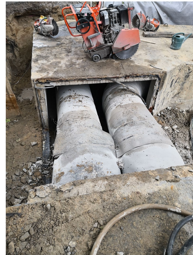
Abbildung: Haubenkanal
