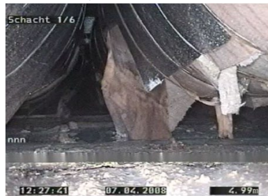
Abbildung 28: im Wasser hängendes Dämmmaterial
