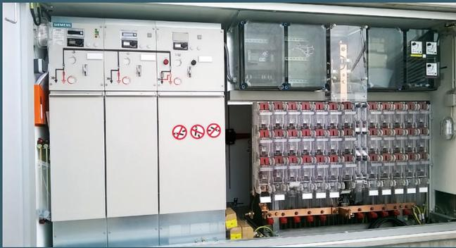
oben: fabrikfertige Trafostation (Innenansicht)
