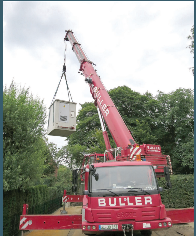
oben: fabrikfertige Trafostation (Innenansicht) unten: individuelle Trafostation mit integriertem Fahrradständer rechts: Aufstellung einer Trafostation mit einem Kran
