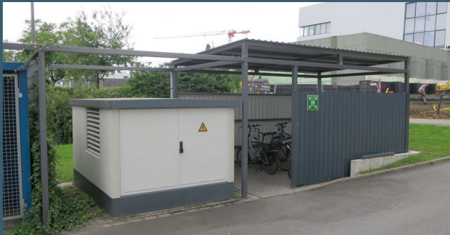
oben: fabrikfertige Trafostation (Innenansicht) unten: individuelle Trafostation mit integriertem Fahrradständer rechts: Aufstellung einer Trafostation mit einem Kran
