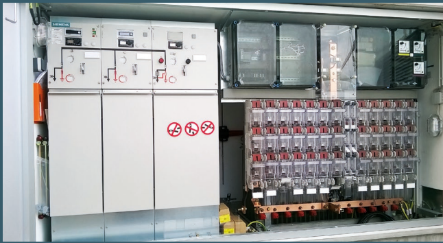
oben: fabrikfertige Trafostation (Innenansicht) unten: individuelle Trafostation mit integriertem Fahrradständer rechts: Aufstellung einer Trafostation mit einem Kran
